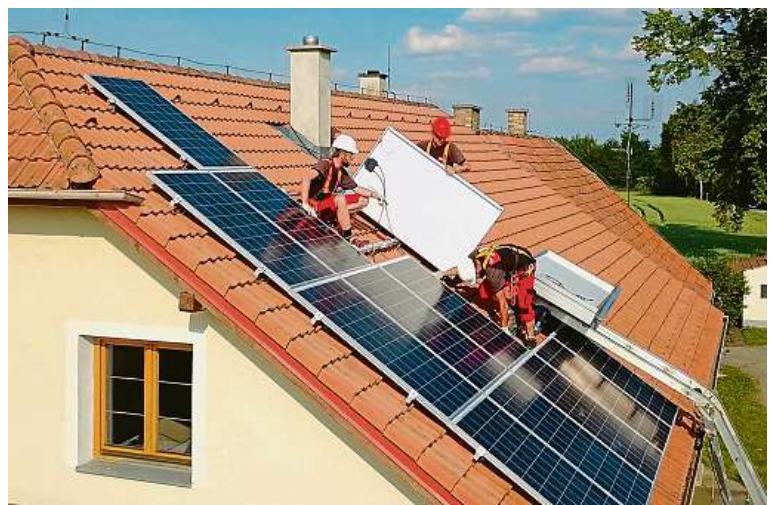
Pracovníci firmy E.ON instalují fotovoltaické panely.
