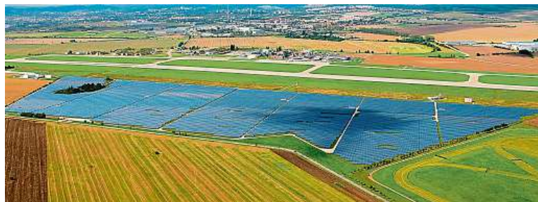
Fotovoltaická elektrárna na volné ploše v Tuřanech.
