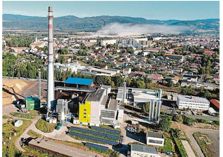
Areál Ostrovské teplárenské se skladem štěpky a biokotelnou, fotovoltaickou elektrárnou, akumulátory tepla a kogeneračními jednotkami.
