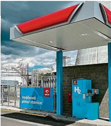
Vodíková stanice v Litvínově
