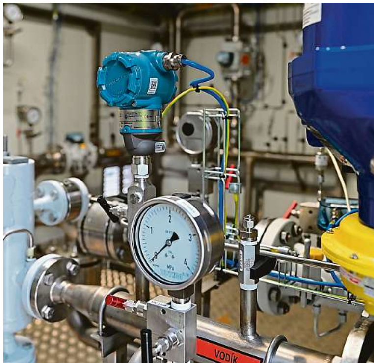
Směšovací technologie v projektu v Hranicích u Aše
