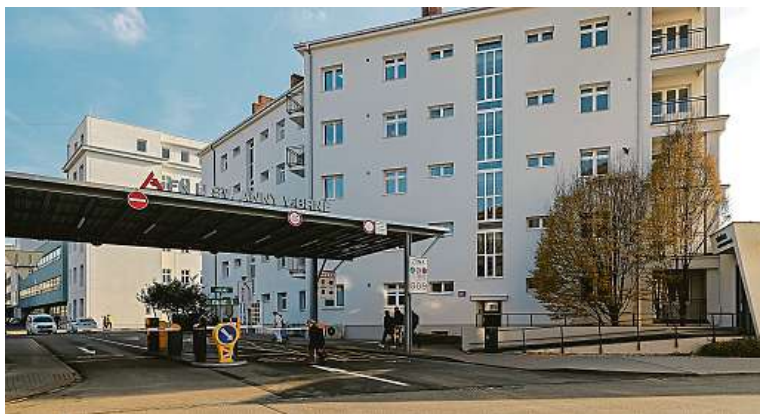
Rekonstrukce FN u sv. Anny v Brně prošla kompletní renovací
