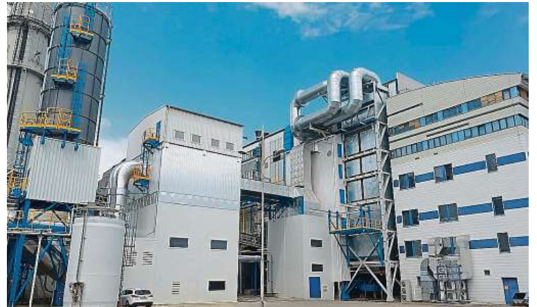
Palivový mix Teplárny dovedou využívat diverzifikovaný palivový mix zahrnující například uhlí, biomasu nebo zbytkový komunální odpad.
