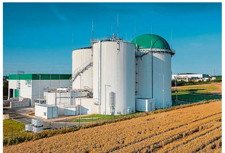
Využití V bioplynové stanici se gastroodpad zpracovává na plyn, který se následně čistí na biometan. Zdroj: Česká asociace odpadového hospodářství
