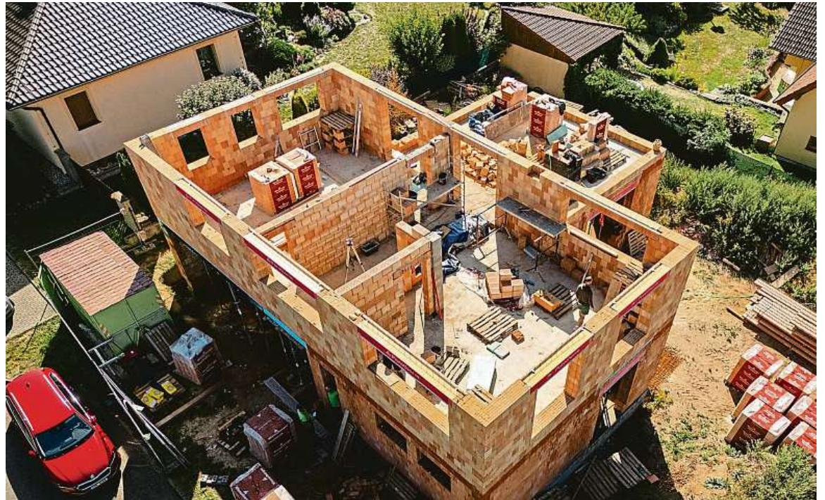
Usnadní a urychlí práci Cihelné bloky Porotherm T Profi a Porotherm EKO Profi obsahují tepelnou a protihlukovou izolaci v podobě minerální vaty.
